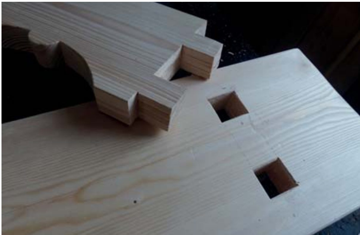
Čepování boku lavice do horního plátku – skrz a zajištění pomocí klínku
