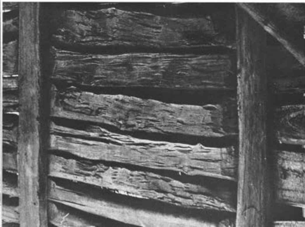
Seník z Deslavic. Detail dražené konstrukce, vyplněné bukovými šípky. Foto St. Šulc, archiv ÚEF – ČSAV Praha.
