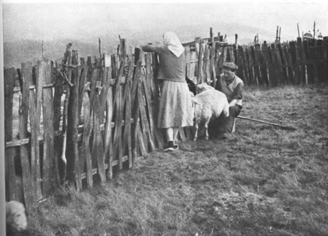
Tynkosoé hrazení s vertikálním sjepletem z Určany. Foto Ivo Stolařík.
