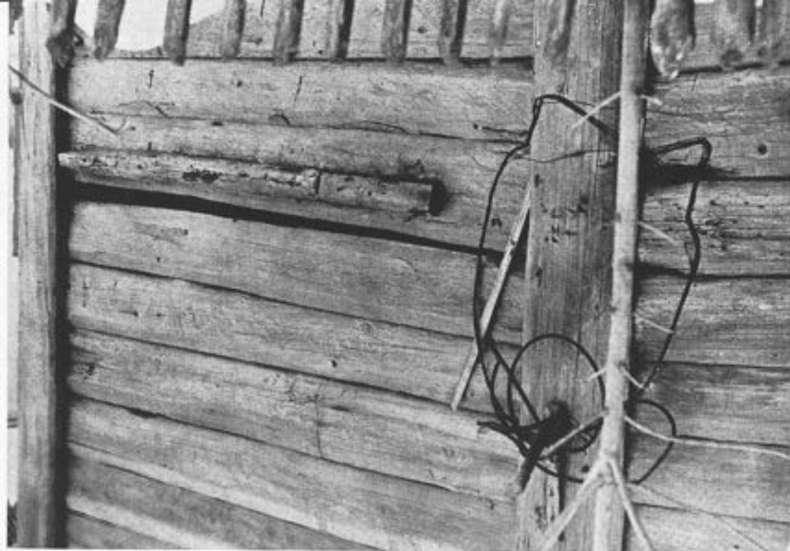
Stěna kálny s draženou konstrukcí vyplněnou šípky a řezanými kralinami. Kozlovice 1890, okr. Frenštát p. R. J. Foto Milan Neraď, archiv ÚEF – ČSAV Praha.
