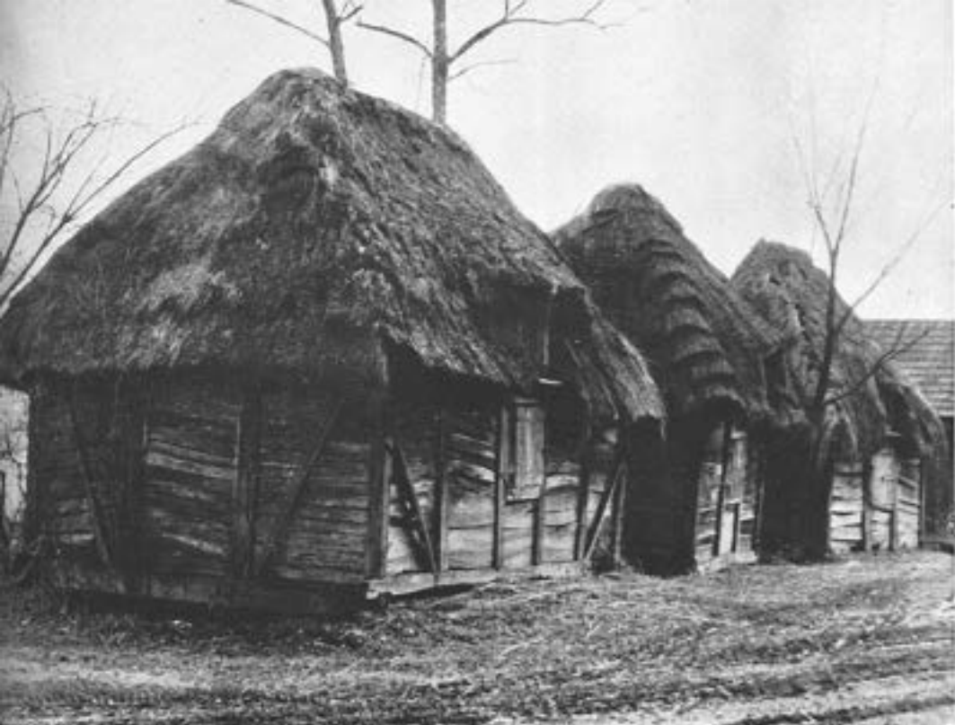
Senky z Drstovic (okr. Uherský Brod). Dražený konstrukce s nadrovně kladenými bukovými šípky. Foto St. Šulc; archiv OEF — ČSAV Praha.
