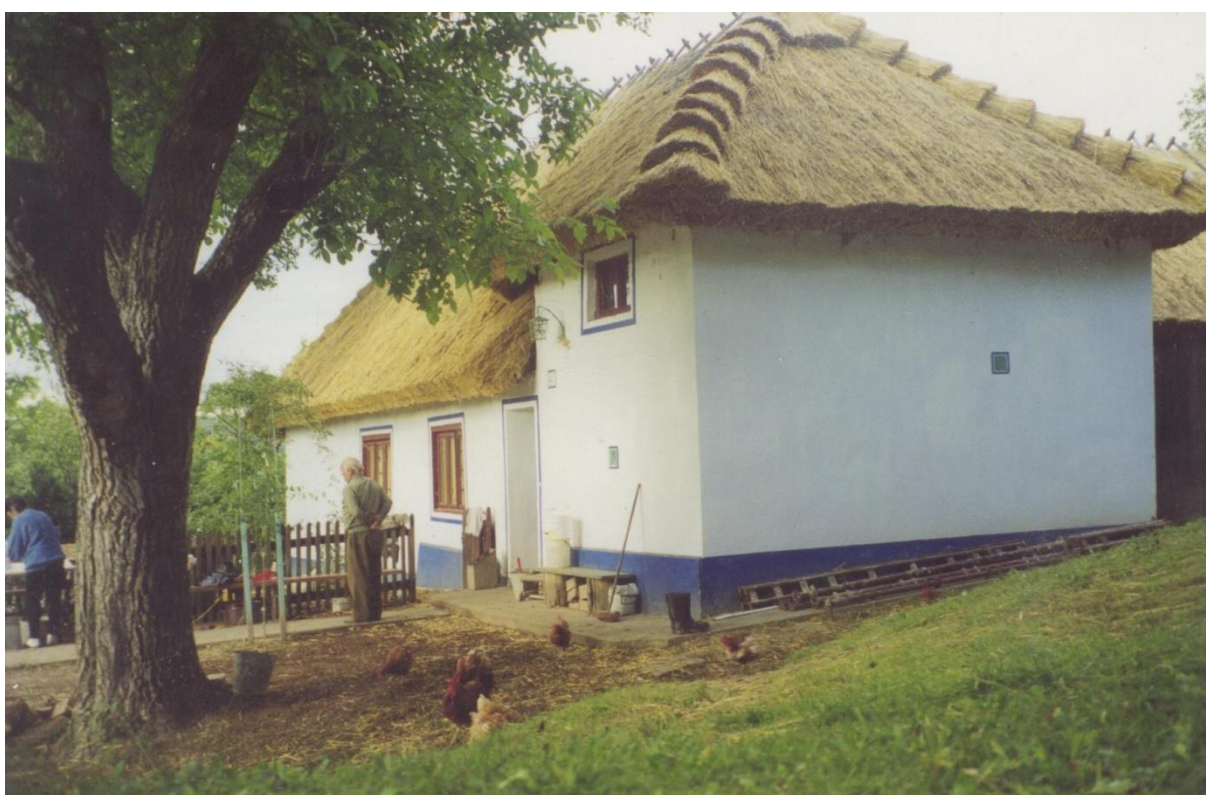
16) Došková krytina na památkově chráněném objektu v obci Lopeník. Realizace v roce 2000
