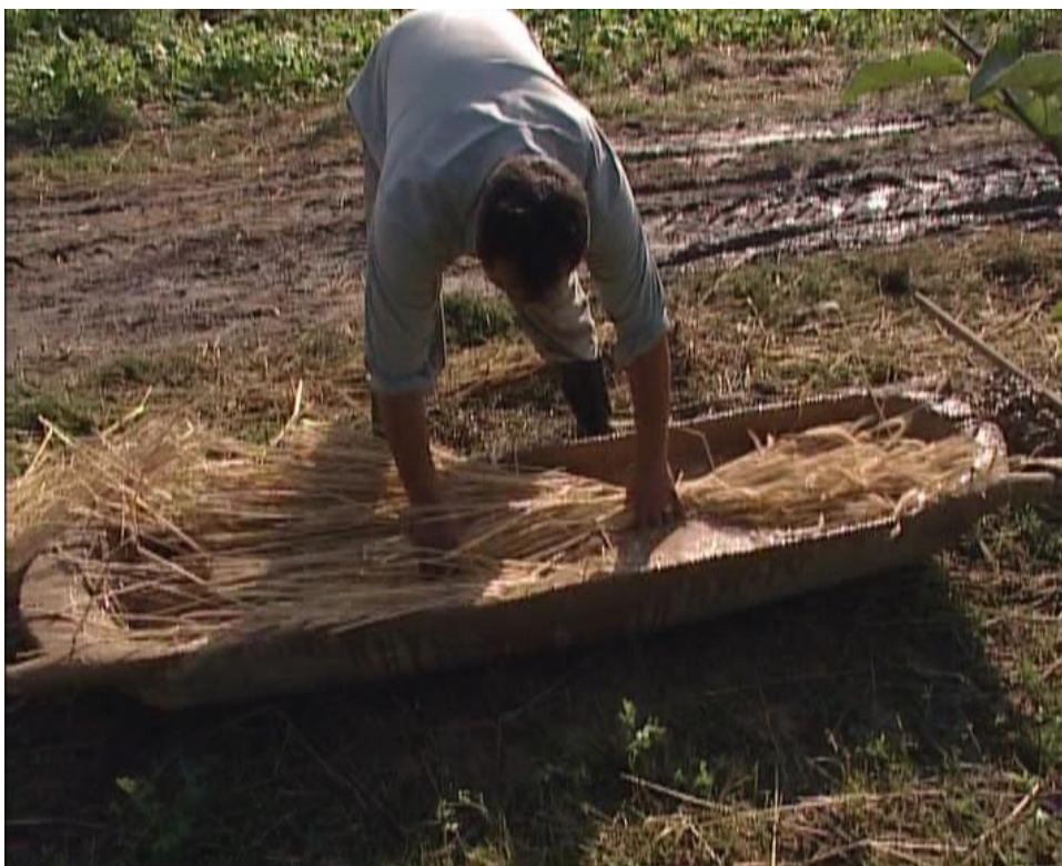
11) Kalení došku v hliněné lázni
