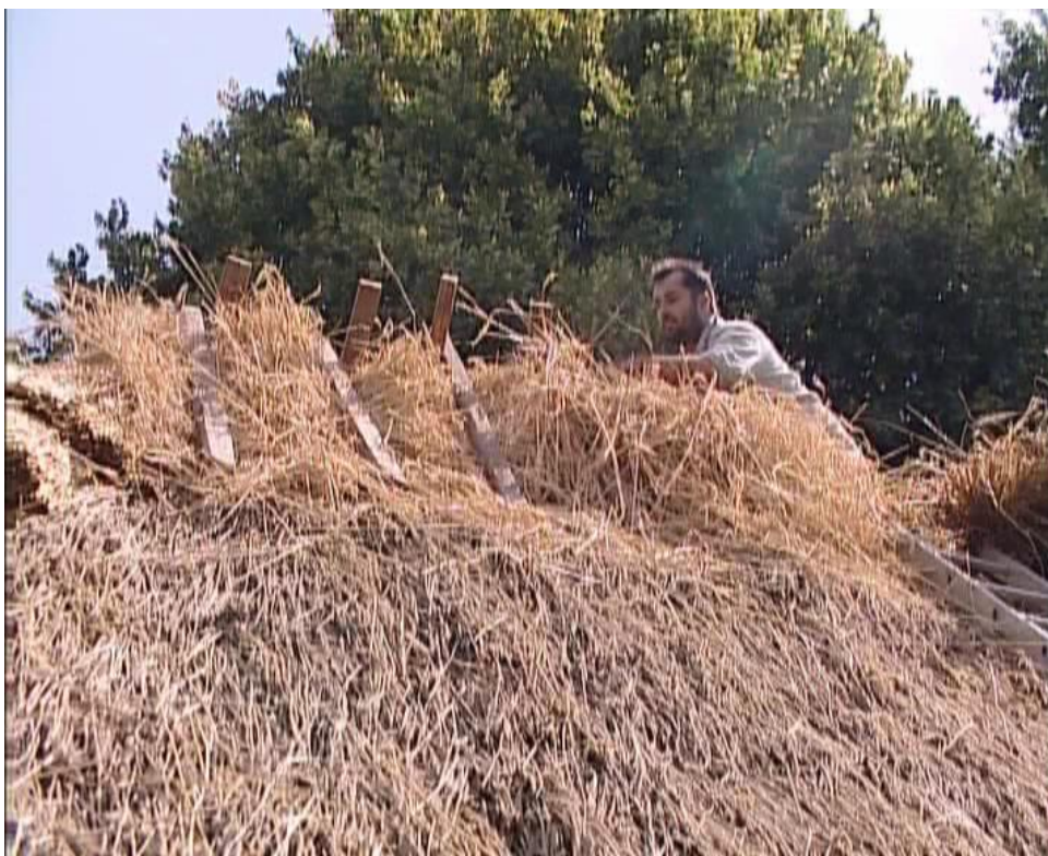
10) Zhotovení hřebene zpevněného kleštinami
