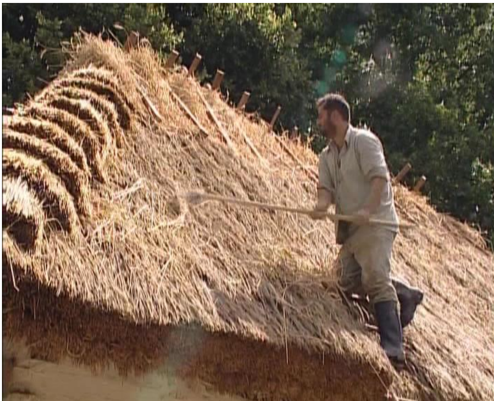
13) Na závěr se střecha „učese“ hráběmi
